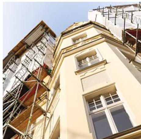
Rénovation complète d'un immeuble
