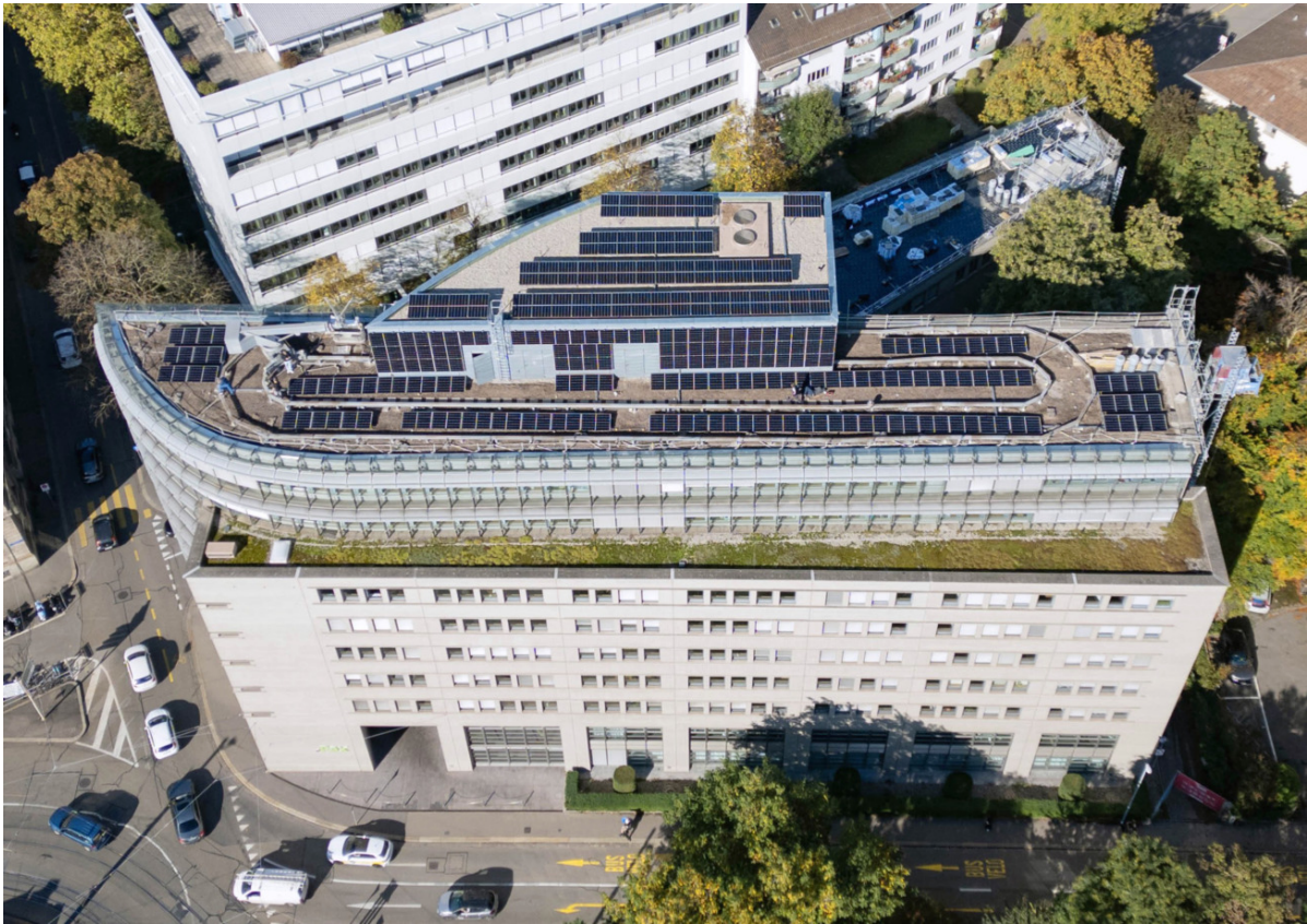
Installation photovoltaïque au siège social de Pax à Bâle
