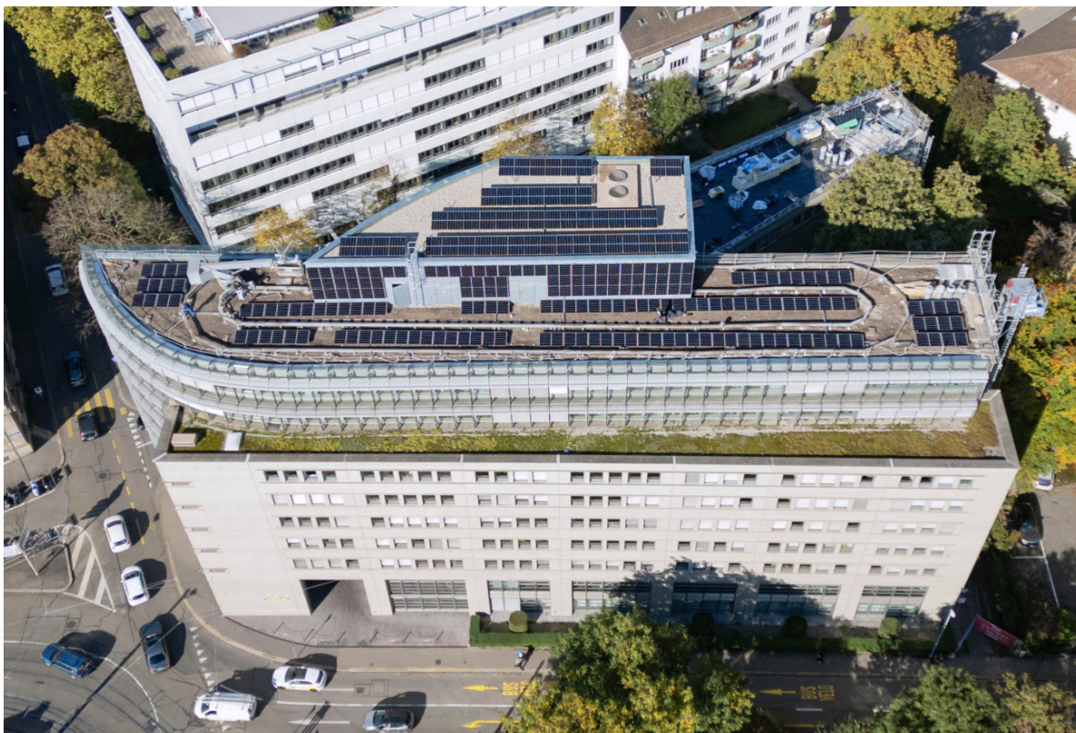
Fotovoltaikanlage am Pax Hauptsitz in Basel
