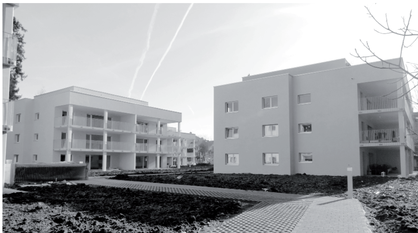
Der Bau der 14 Eigentumswohnungen in der Überbauung Bürglen, Schützenpark wurde im Dezember 2010 vollendet.
