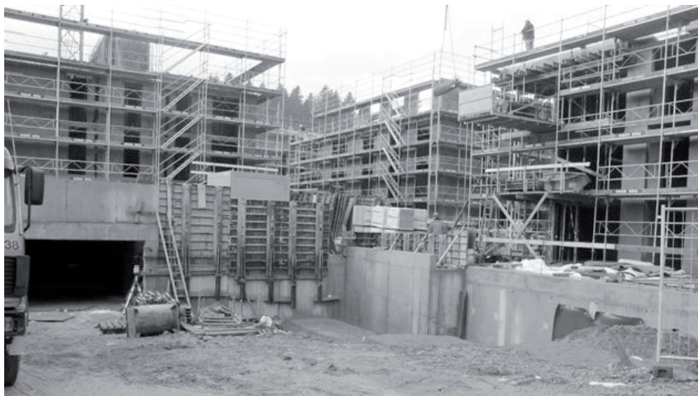
In Hausen entsteht die Überbauung Residenza Verde mit zwei Mehrfamilienhäusern.
