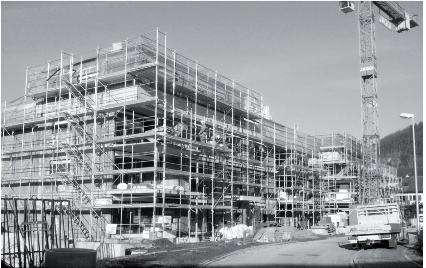
Die Überbauung Sunpark in Würenlos mit zwei Mehrfamilienhäusern mit je 10 Eigentumswohnungen wird im Sommer 2011 bezugsbereit.
